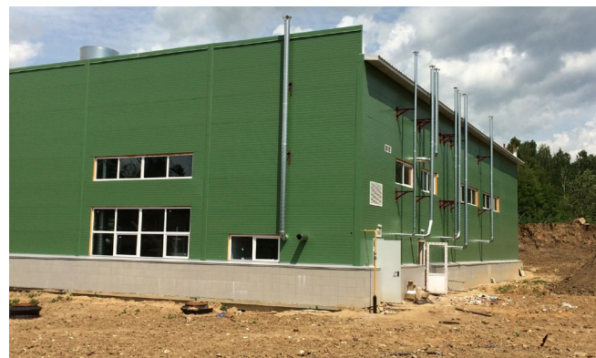
Возведение здания доочистки и обеззараживания сточных вод на птицефабрике АО «Калужская»
