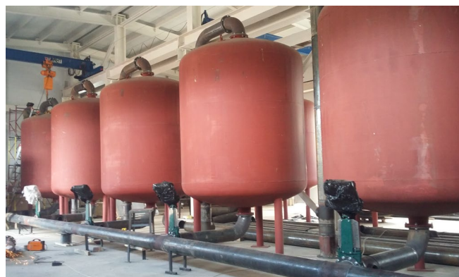
Строительство локальных очистных сооружений с нуля «под ключ» для «A101»
