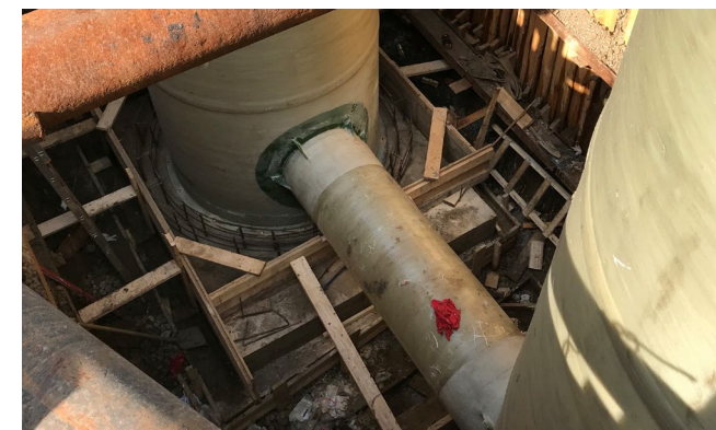
Строительство комплексной системы насосных станций для АО «МОСКОКС»
