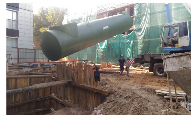
Строительство очистных сооружений, насосной станции, внеплощадочных сетей бытовой канализации в клубном квартале AFI Residence
