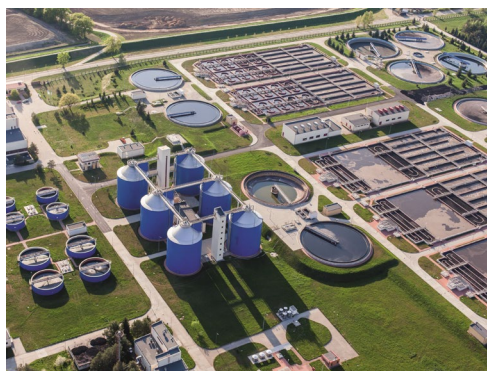
Комплексные очистные сооружения
