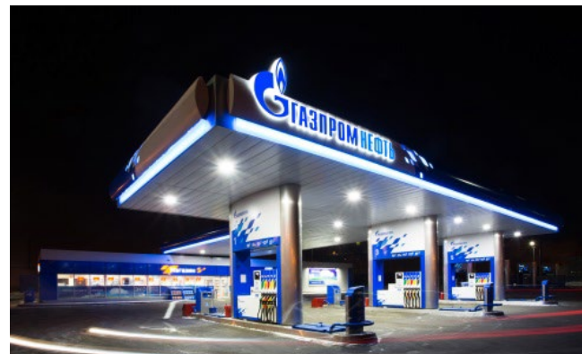
Производство, монтаж системы ливневой очистки на станции АЗС Газпром нефть в Москве и МО
