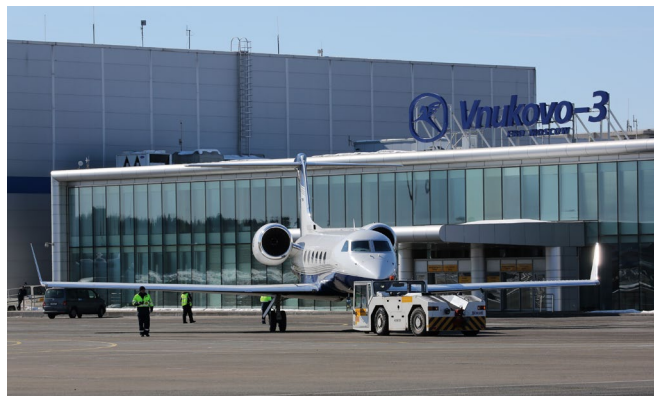
Производство, монтаж системы биологической очистки HELIX в аэропорт Внуково-3. Москва
