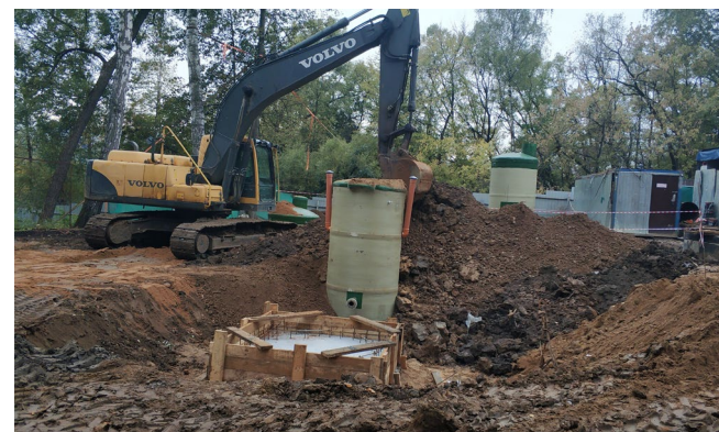
Строительно-монтажные и пусконаладочные работы по локальным очистным сооружениям Нагорное
