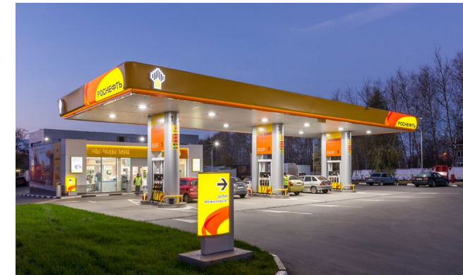
Производство, поставка системы ливневой очистки на станции АЗС Роснефть в Москве и МО
