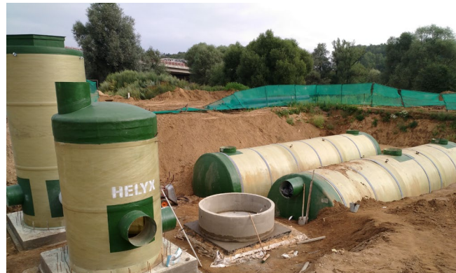
Работы «под ключ» по строительству очистных сооружений поверхностного стока для МОИСС ЦКАД
