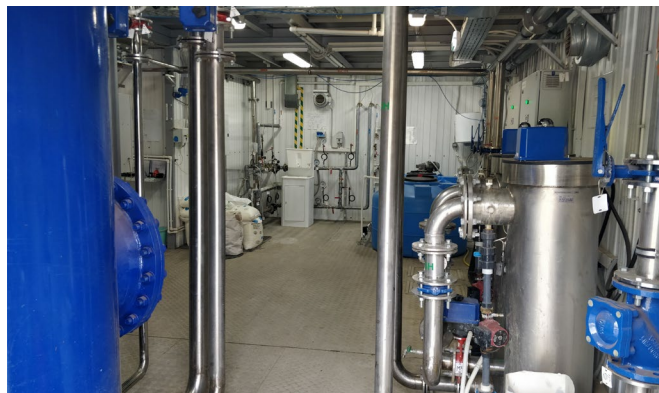
Строительство очистных сооружений для Семейного торгового центра «МЕГА Ростов»
